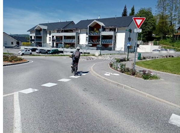
Aménagement sur trottoir non réglementaire – La-Balme-de-Sillingy
