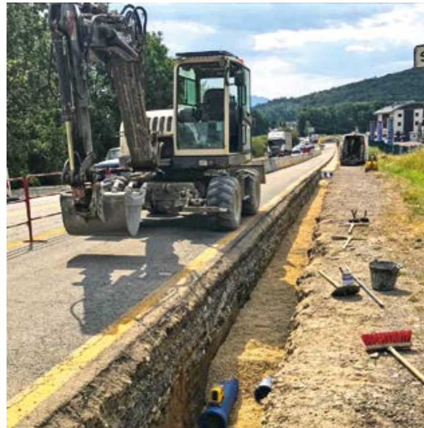
Travaux de renouvellement de canalisation - RD 1508
